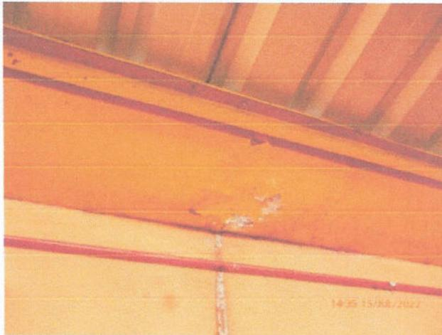
**FIGURA 14 - Ponto de sobrecarga de água em calha**
