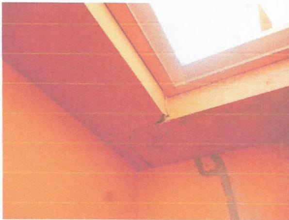
**FIGURA 2 - Laje com rachadura e ponto de infiltração**
