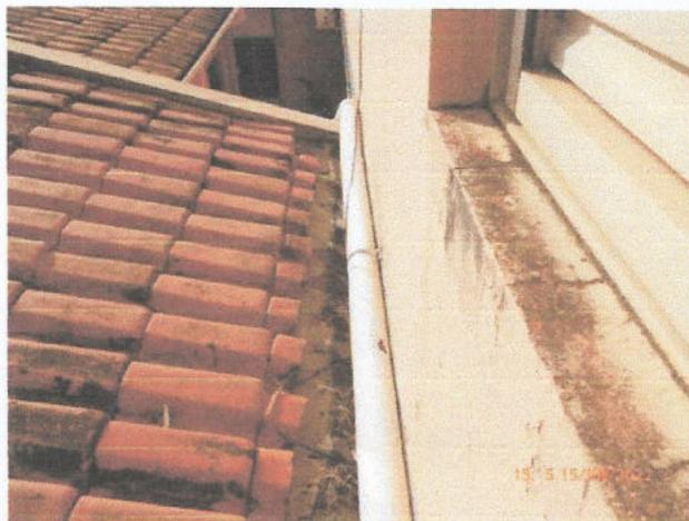
**FIGURA 6 - Vazamento de calha e infiltração em janela**
