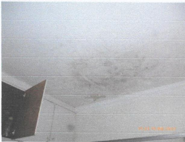
**FIGURA 20 - Infiltração de água laje alojamento 2**
