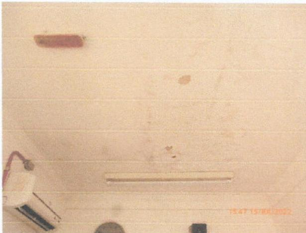
**FIGURA 8 - Infiltração de água laje - Sala de Comunicações /Atendimento**
