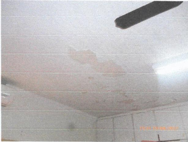
**FIGURA 19 - Laje com presença de umidade - Alojamento 2**
