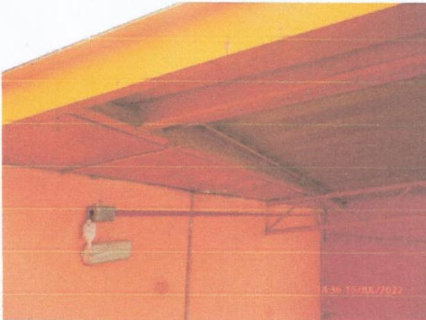
**FIGURA 22 - Calha com excesso de contribuição garagem**
