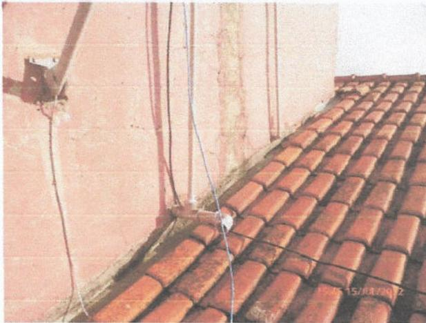
**FIGURA 11 - Pontos de infiltração e deficiência na impermeabilização**
