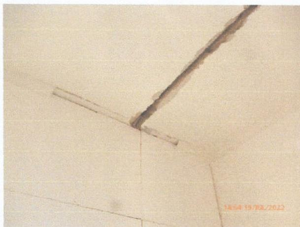
**FIGURA 3 - Laje interna com rachadura - separação entre as lajes**
