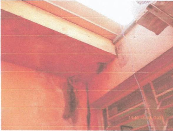
**FIGURA 1 - Rachadura e infiltração**
