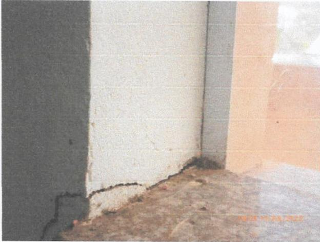
**FIGURA 4 - Base de pilar com rachadura**
