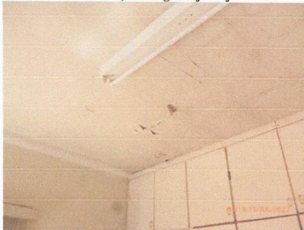
**FIGURA 21 - Infiltração aparente em laje do alojamento 1 - pav. superior**
